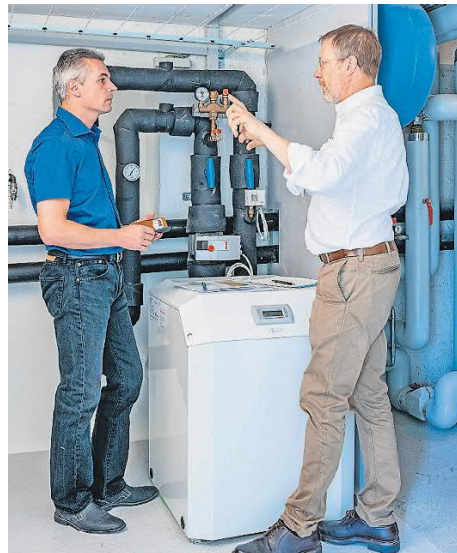
Energie-Coach Reto Niedermann (links) und Hausbesitzer Daniel Baumann vor der neuen Erdsonden-Wärmepumpe im Keller, die das Gebäude ohne fossile Energien heizt.
